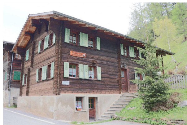
Fassaden Nord-West und Süd-West
