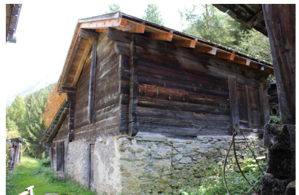
Fassaden Nord und West
