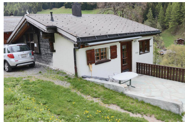
Fassaden Nord und West
