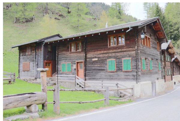
Fassaden Nord-Ost und Nord-West
