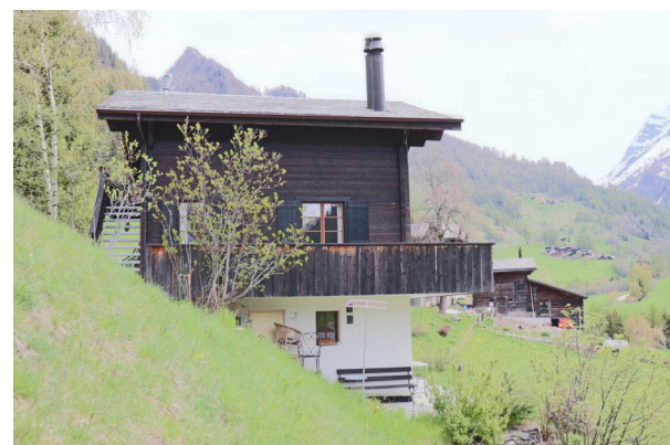
Fassaden Nord-West und Süd-West
