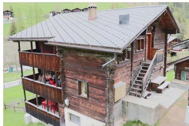
Fassaden Süd-West und Süd-Ost
