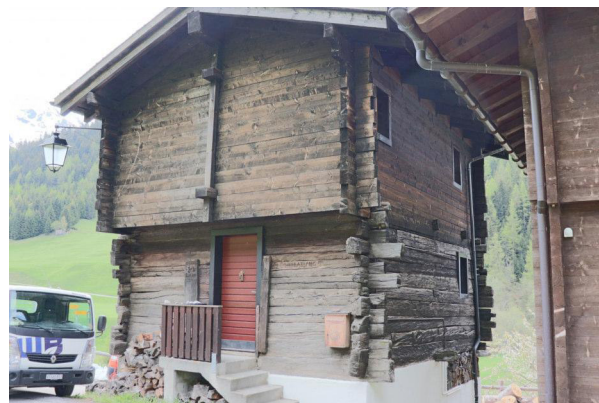
Fassaden Nord und West
