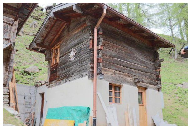
Fassaden West und Nord
