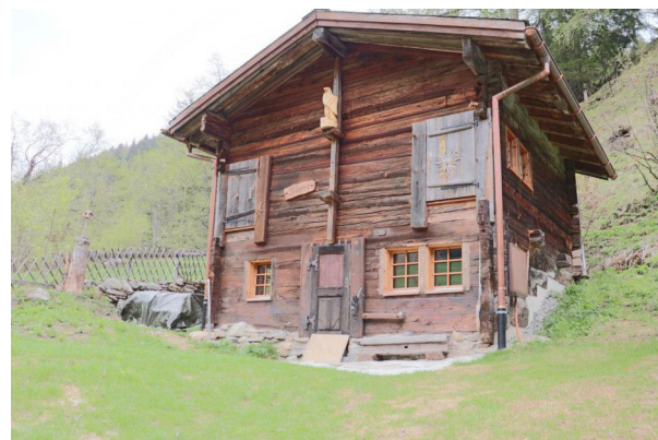
Fassaden Nord und West
