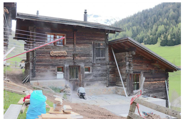
Fassaden Nord und West
