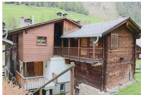
Fassaden Nord-Ost und Süd-Ost
