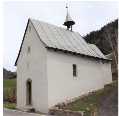
Fassaden Nord und West
