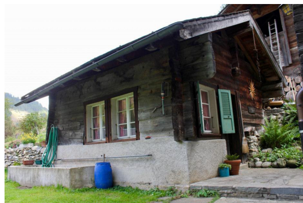
Fassaden Nord-West und Süd-West
