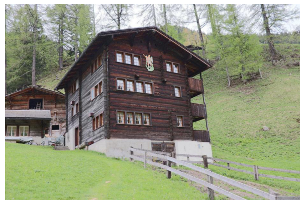
Fassaden Nord-Ost und Nord-West
