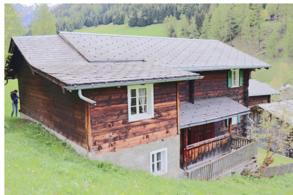
Fassaden Nord und West
