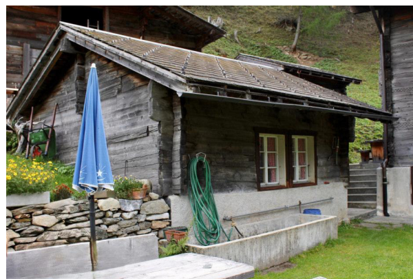
Fassaden Nord-Ost und Nord-West
