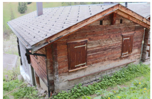
Fassaden Ost und Nord
