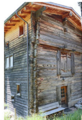
Fassaden Süd-Ost und Nord-Ost
