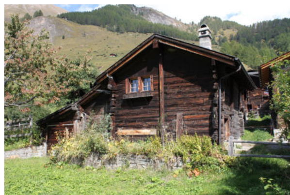
Fassaden West und Süd
