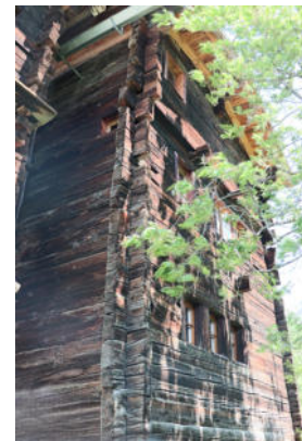
Fassaden Nord-West und Süd-West
