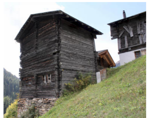
Fassaden Süd-Ost und Nord-Ost
