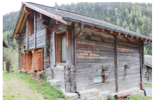
Fassaden Nord-Ost und Nord-West
