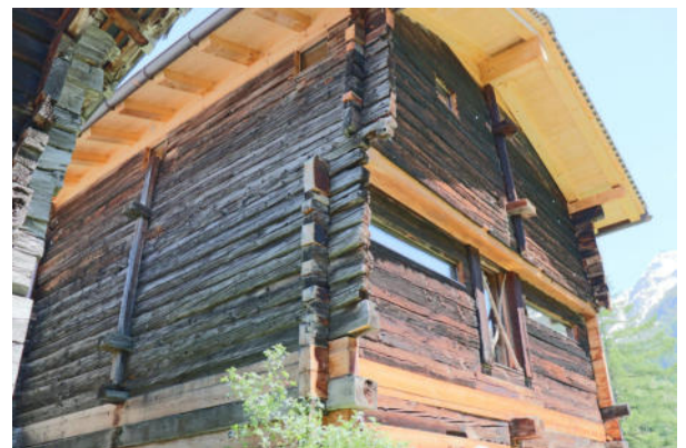
Fassaden Nord-West und Süd-West
