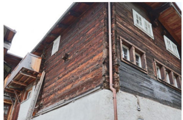
Fassaden Süd-Ost und Süd-West
