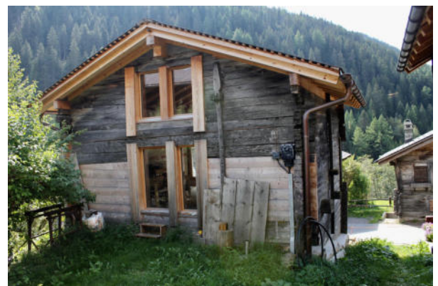
Fassaden Nord-Ost und Nord-West
