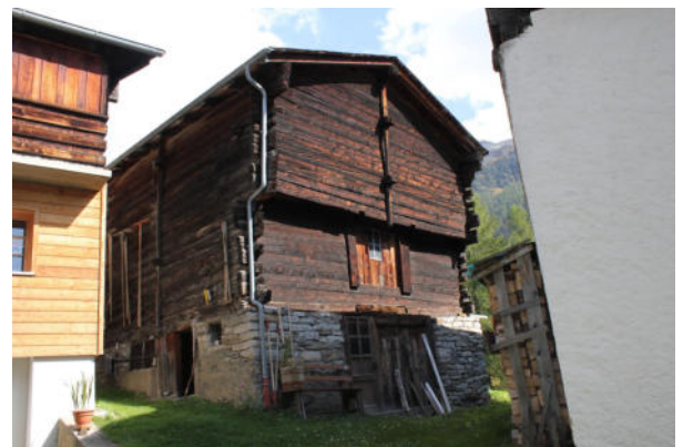
Fassaden Nord-West und Süd-West
