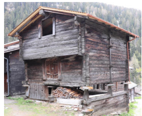
Fassaden Süd-Ost und Nord-Ost
