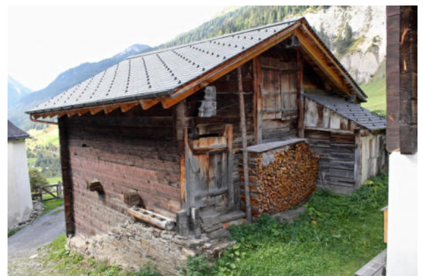
Fassaden Ost und Süd
