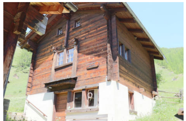
Fassaden West und Süd
