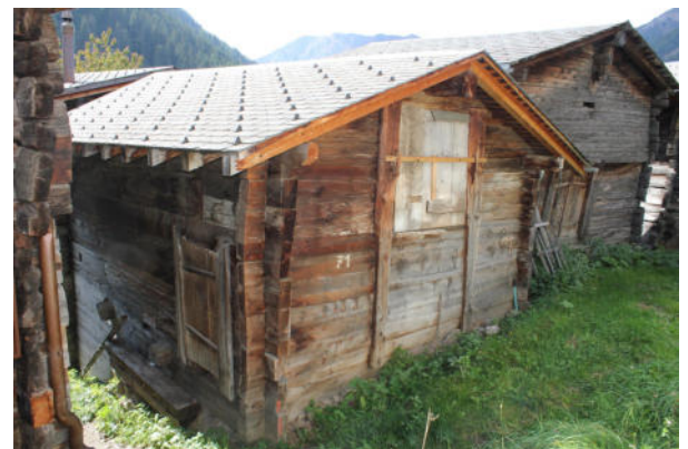
Fassaden Süd-Ost und Nord-Ost
