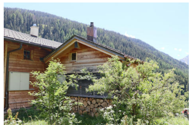
Fassaden Nord-Ost und Nord-West
