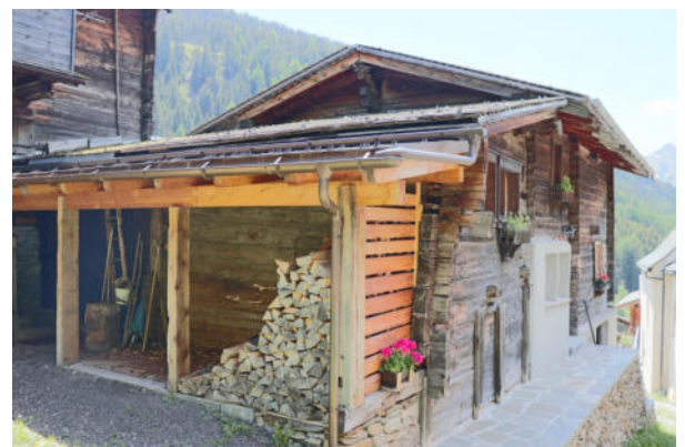
Fassaden Nord-Ost und Nord-West
