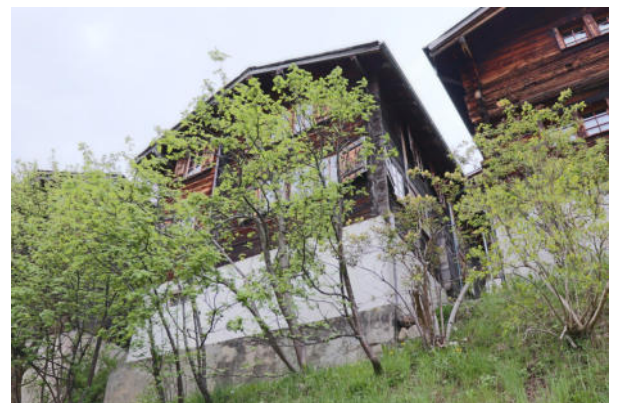
Fassaden Süd und Ost
