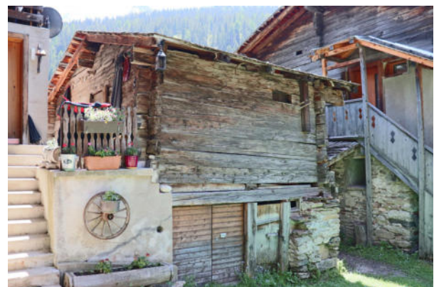
Fassaden Nord-Ost und Nord-West
