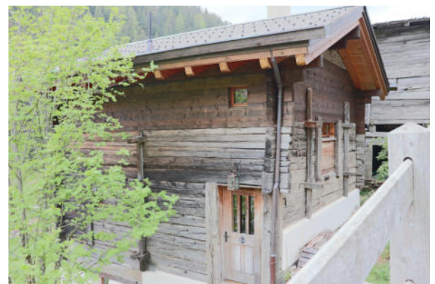
Fassaden Ost und Nord
