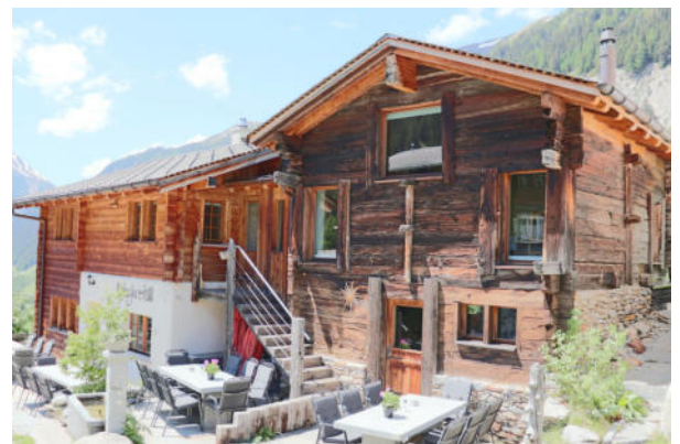
Fassaden Süd-Ost und Nord-Ost
