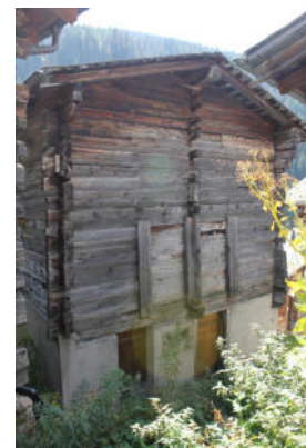
Fassaden Süd-Ost und Nord-Ost
