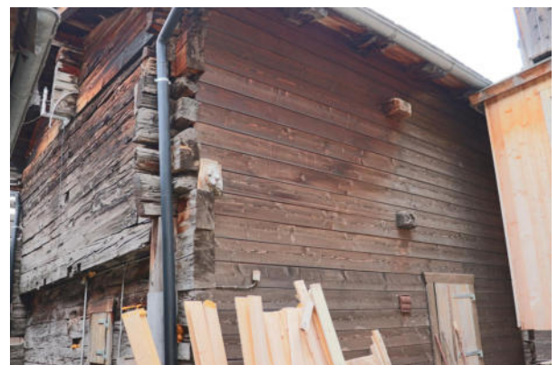
Fassaden Süd-Ost und Nord-Ost
