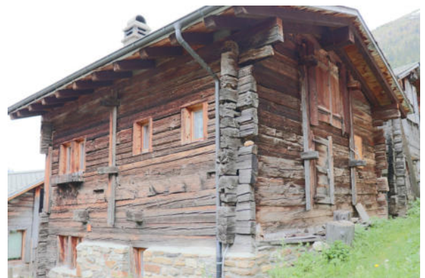
Fassaden Nord-Ost und Nord-West
