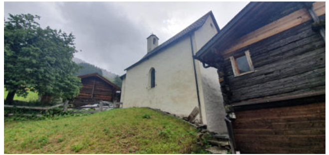
Ansicht von Westen, 22.06.2022 (Foto DIB, sp).
