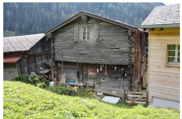
Fassaden Nord-Ost und Nord-West
