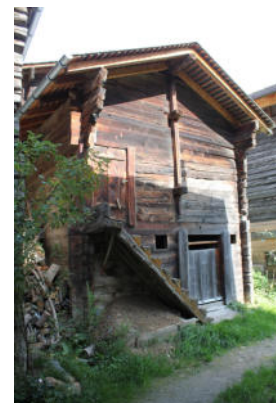
Fassaden Nord-West und Süd-West
