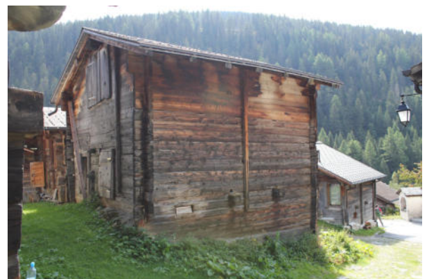
Fassaden Süd-Ost und Nord-Ost
