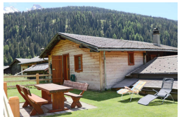
Fassaden Nord-Ost und Nord-West
