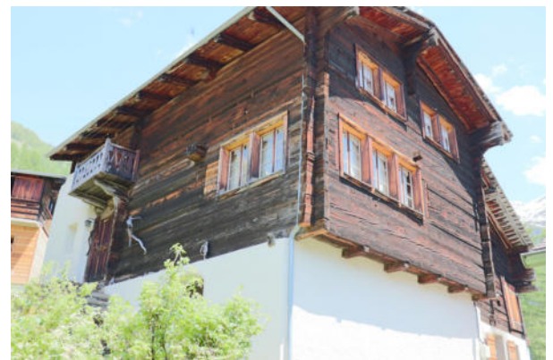
Fassaden Nord-West und Süd-West
