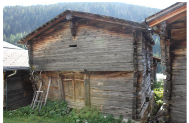
Fassaden Nord-Ost und Nord-West
