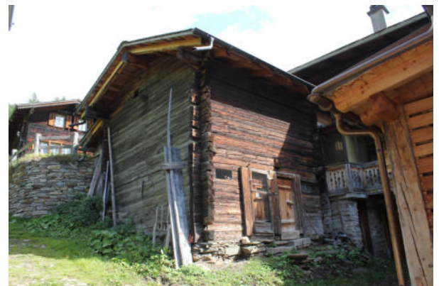
Fassaden Nord-West und Süd-West
