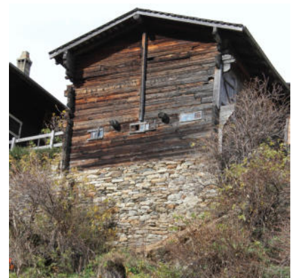
Fassaden Süd und Ost
