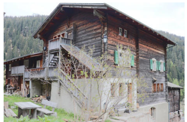
Fassaden Nord-Ost und Nord-West
