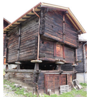
Fassaden Nord-Ost und Nord-West
