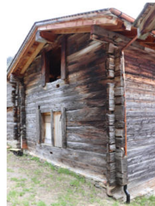
Fassaden Nord-Ost und Nord-West
