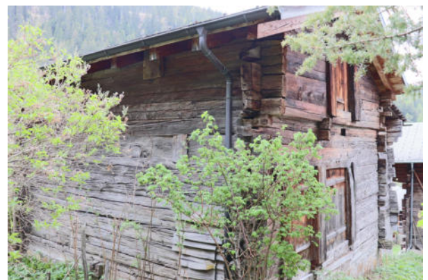
Fassaden Nord-Ost und Nord-West
