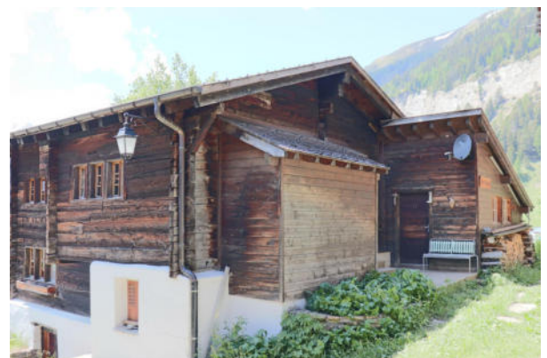
Fassaden Süd-Ost und Nord-Ost
