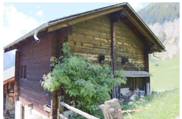
Fassaden Süd und Ost
