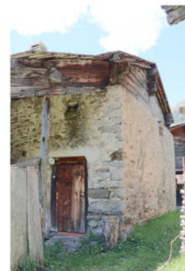
Fassaden Süd-Ost und Nord-Ost
