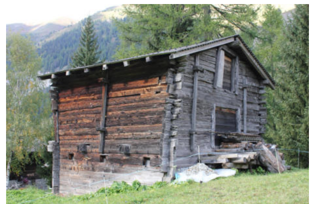
Fassaden Süd und Ost
