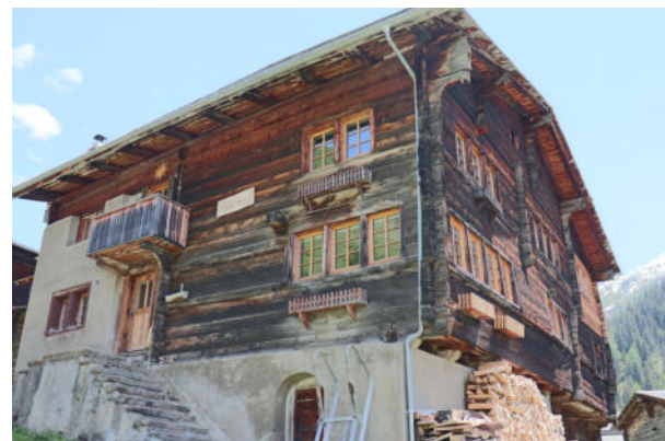
Fassaden Nord-West und Süd-West
