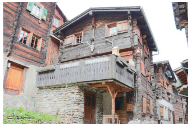
Fassaden Nord-West und Süd-West
