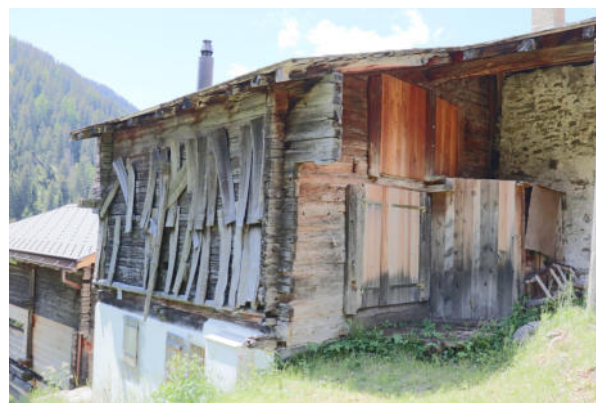
Fassaden Süd-Ost und Nord-Ost
