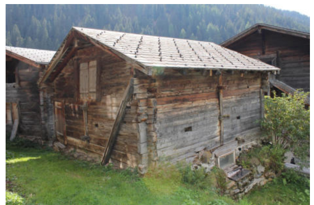
Fassaden Nord-Ost und Nord-West
