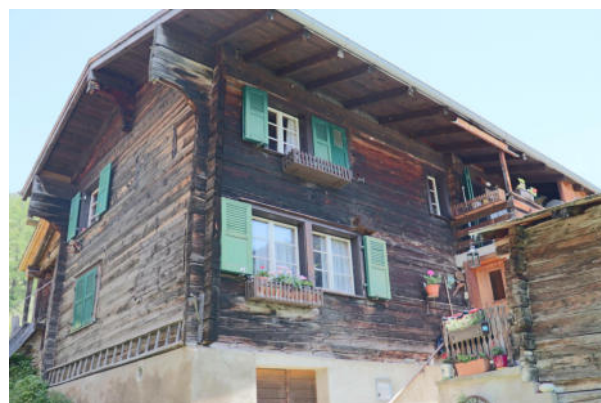
Fassaden Nord-West und Süd-West
