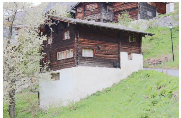
Fassaden Süd und Ost
