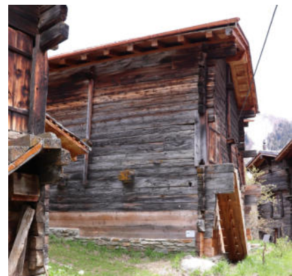
Fassaden Nord-West und Süd-West
