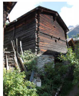
Fassaden Nord-West und Süd-West
