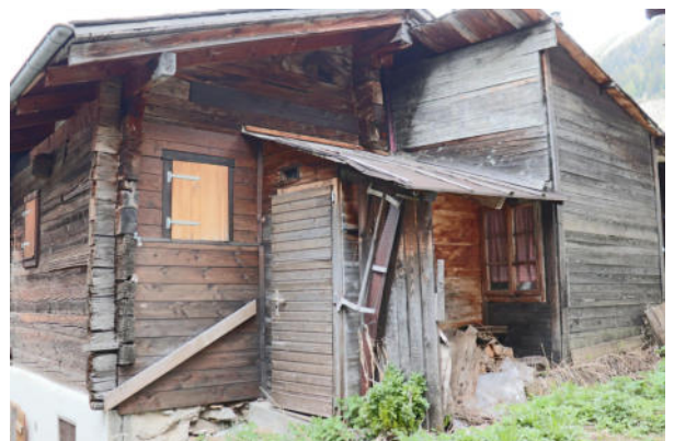
Fassaden Nord-Ost und Nord-West
