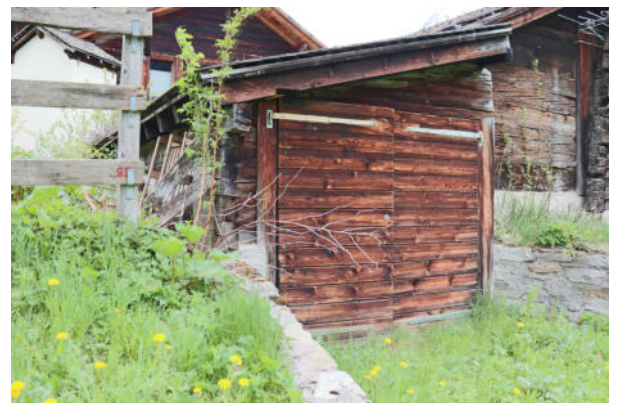
Fassaden Nord-West und Süd-West
