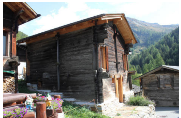
Fassaden Nord-West und Süd-West
