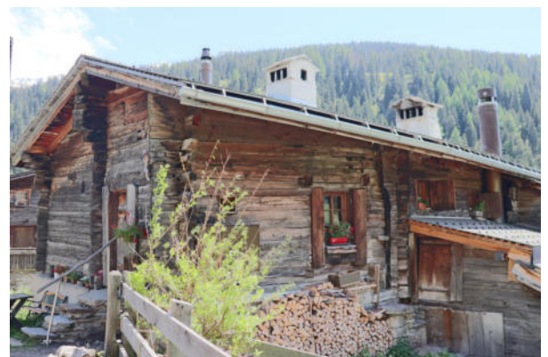
Fassaden Nord-Ost und Nord-West
