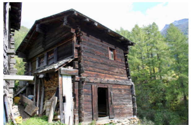
Fassaden Nord-West und Süd-West
