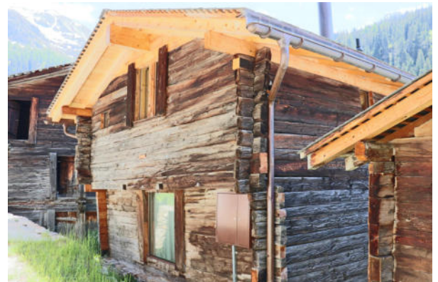
Fassaden Nord-Ost und Nord-West
