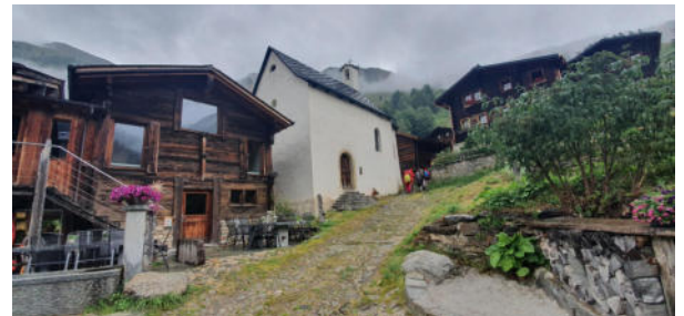
Ansicht von Süden, 22.06.2022 (Foto DIB, sp).
