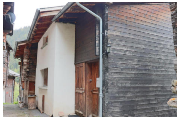
Fassaden Nord-Ost und Nord-West
