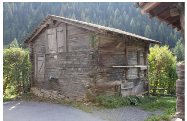
Fassaden Nord-Ost und Nord-West
