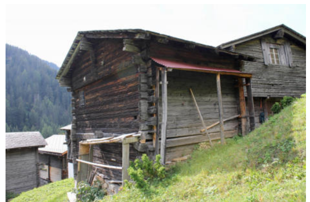
Fassaden Süd-Ost und Nord-Ost
