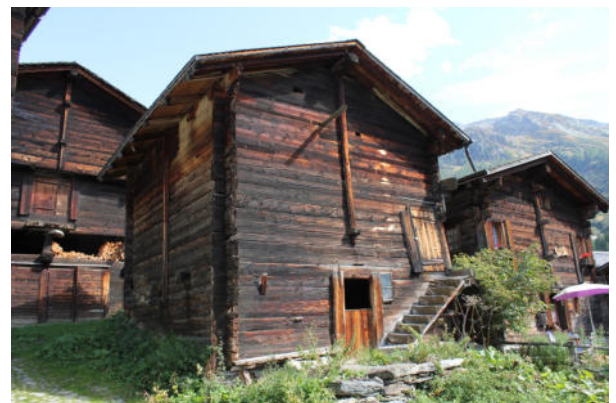
Fassaden Nord-Ost und Nord-West
