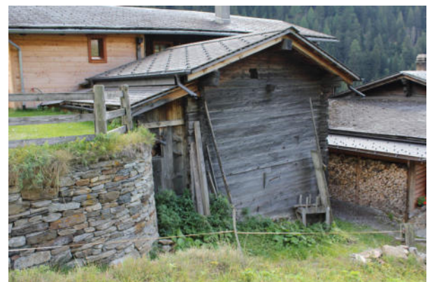
Fassaden Nord-Ost und Nord-West
