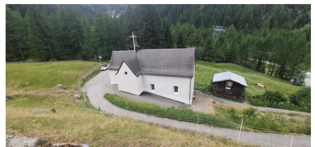
Ansicht von Nordosten, 22.06.2022 (Foto DIB, sp).
