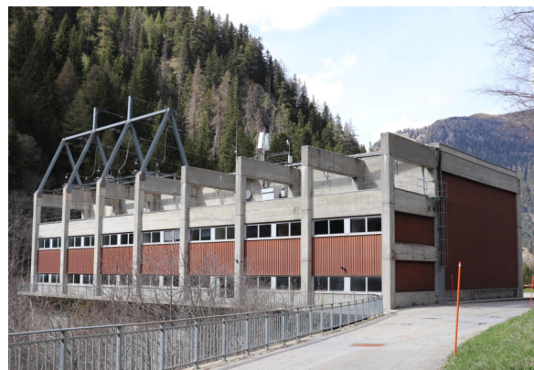
Fassaden Süd und Ost
