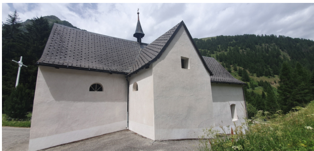
Ansicht von Osten, 22.06.2022 (Foto DIB, sp).
