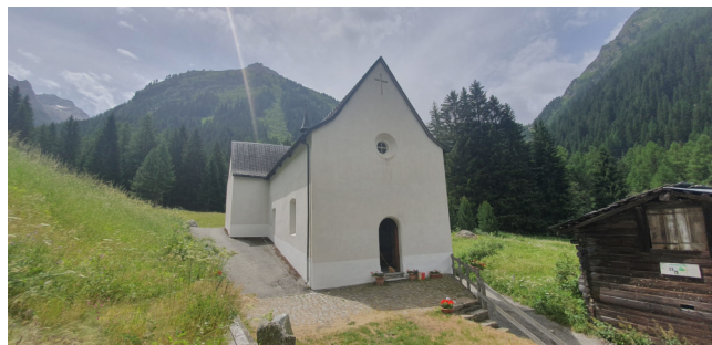
Ansicht von Norden, 22.06.2022 (Foto DIB, sp).
