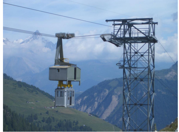
Stütze, Fahrbetriebsmittel (© BAK / Erwin Bloch, CH-3627 Heimberg).
