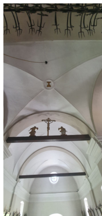
Vierung und Langhaus, Gewölbe, 22.06.2022 (Foto DIB, sp).
