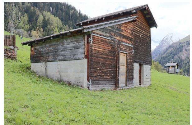
Fassaden Nord-Ost und Nord-West
