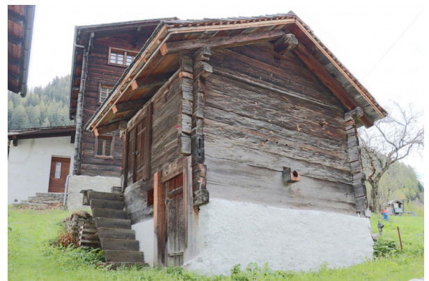
Fassaden Nord-Ost und Nord-West
