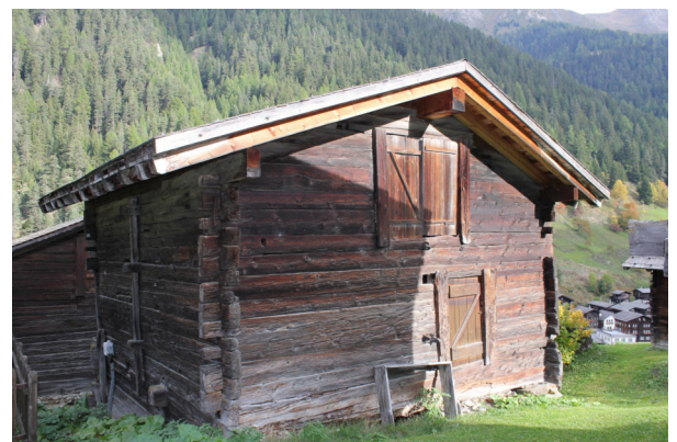
Fassaden Nord-Ost und Nord-West
