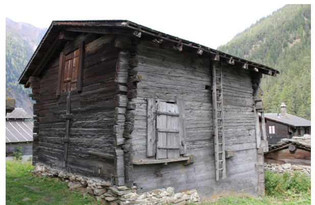
Fassaden Nord-Ost und Nord-West
