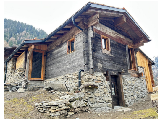
Fassaden Nord-Ost und Nord-West
