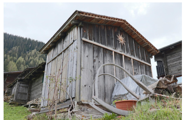
Fassaden Nord-Ost und Nord-West
