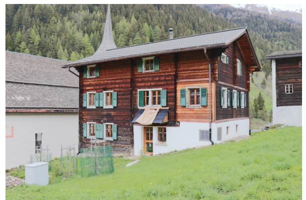
Fassaden Süd-West und Süd-Ost
