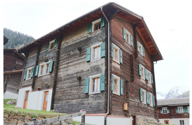
Fassaden Nord-Ost und Nord-West
