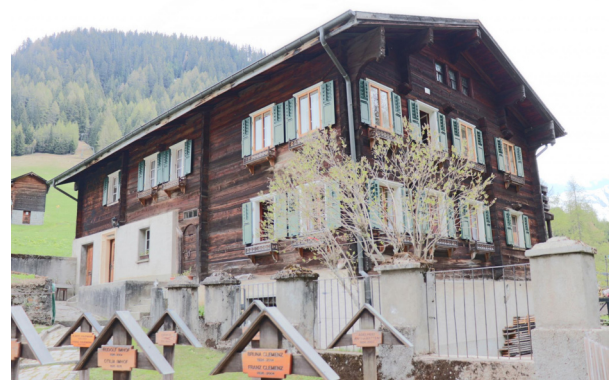
Fassaden Nord-Ost und Nord-West
