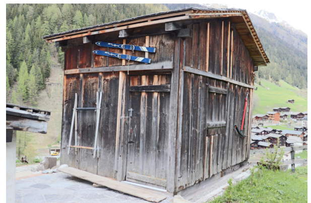
Fassaden Süd-West und Süd-Ost
