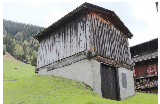
Fassaden Nord-Ost und Nord-West
