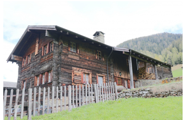
Fassaden Nord-West und Süd-West
