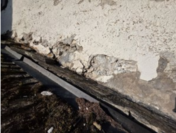
Detail loser Putz, welcher sich voraussichtlich durch liegen gebliebene Feuchte gelöst hat.
