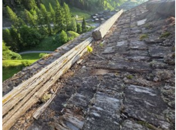
Detail Schneefang. Morsche Balken. Ablagerungen sichtbar. Material von Morschen Schindeln, Baumnadeln, Moos usw. sammeln sich an. Vereinzelt wachsen sogar Pflanzen.
