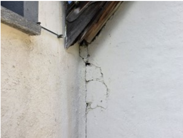
Detail Gebäudeecken im Dachbereich. Durch Bewegung vom Holz sowie Feuchte, löst sich der Putz.
