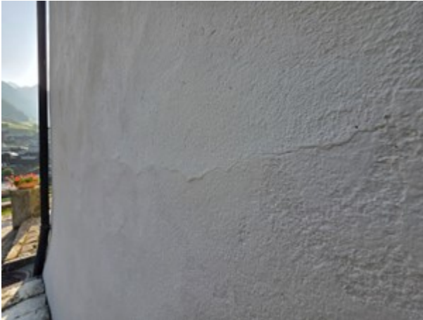
Horizontalriss Nordfassade: Loser Putz auf ca. 1m Höhe. Der Putz ist auf die gesamte Länge, welche als Riss sichtbar ist, lose.
