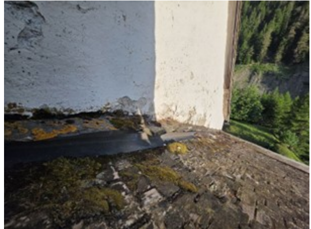
Detail Dach-Wandanschluss mit Moosbildung auf den Schindeln, Blech und Abschlusssteine. Loser Putz oberhalb der Abschlusssteine, resp. der Randbleche.
