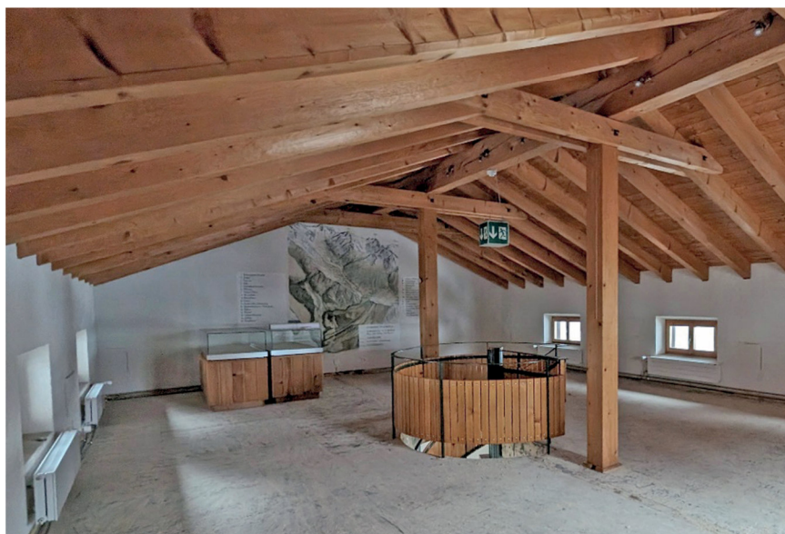
DAS REGIONALMUSEUM IN BINN VOR DEM UMBAU.
